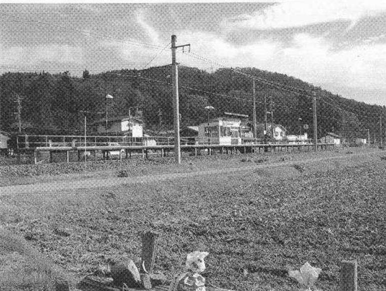
G地点から稲尾駅を見えています。掘っ建て小屋つぶりが素敵です。
